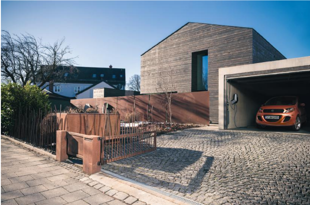
Bild 2: Ladeeinrichtung für Elektrofahrzeuge auf einem privaten Grundstück
